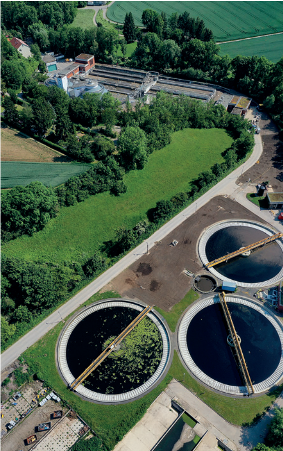
Luftaufnahme der Nachklärbecken im Gruppenklärwerk Ditzingen.
