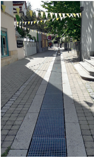
Oben: Rinne zur Ausleitung von Nesenbachwasser in der Nesenbachstraße im Stuttgarter Gerberviertel.
