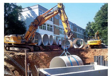
Regenüberlaufkanal Hohlgraben: Verlegung von GFK-Rohren DN 2800, Drachenprofil.
