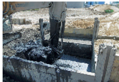
Nassauschub im Verbauelement vorne. Das Element dahinter ist bereits mit Kies verfüllt.
