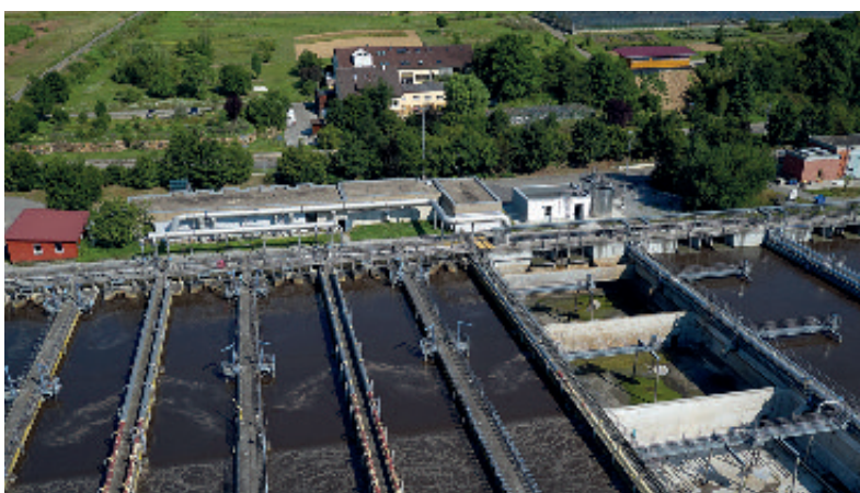
Belebungsbecken der biologischen Stufe BKA01 mit der neuen Fällmittelstation.
