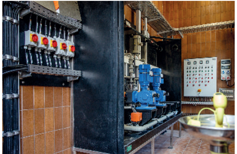
Innenraum der Fällmittelstation am Sandfilter. Zu sehen sind die beiden Dosierpumpen (blau) und dahinter die beiden Reserveplätze zur Erweiterung.
