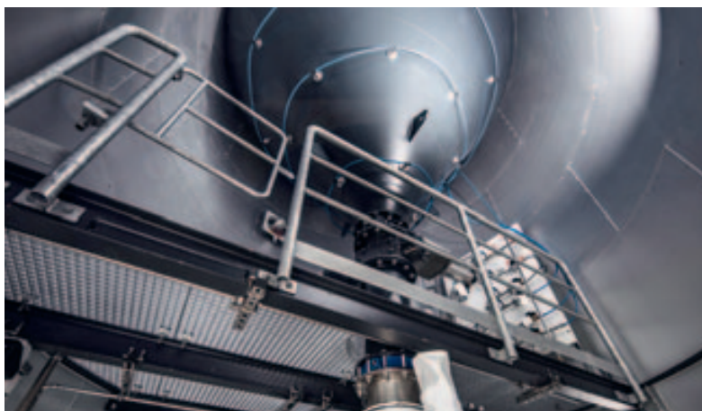
Blick nach oben in der Silozarge. Zu sehen ist der Austragspunkt aus dem Silo in die eigentliche Dosiereinrichtung.
