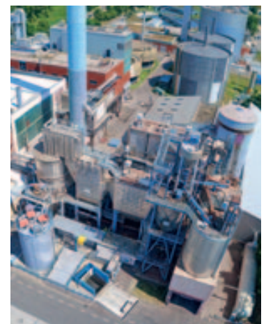
Wirbelschichtofen 2 mit nachgeschalteter Rauchgasreinigung und Klärschlammannahme 1.
