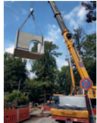
Einbau eines Teils des Trennbauwerks für den RÜK Falkenstraße.
