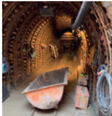
Stollenvortrieb unter den Stuttgarter Straßenbahngleisen für den RÜK Landhausstraße.
