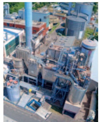
Wirbelschichtofen 2 mit nachgeschalteter Rauchgasreinigung und Klärschlammannahme 1.
