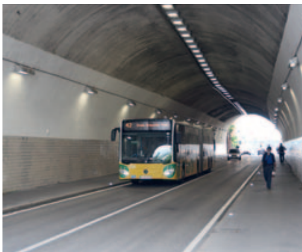
Neue LED-Beleuchtungsanlage im Schwabtunnel.
