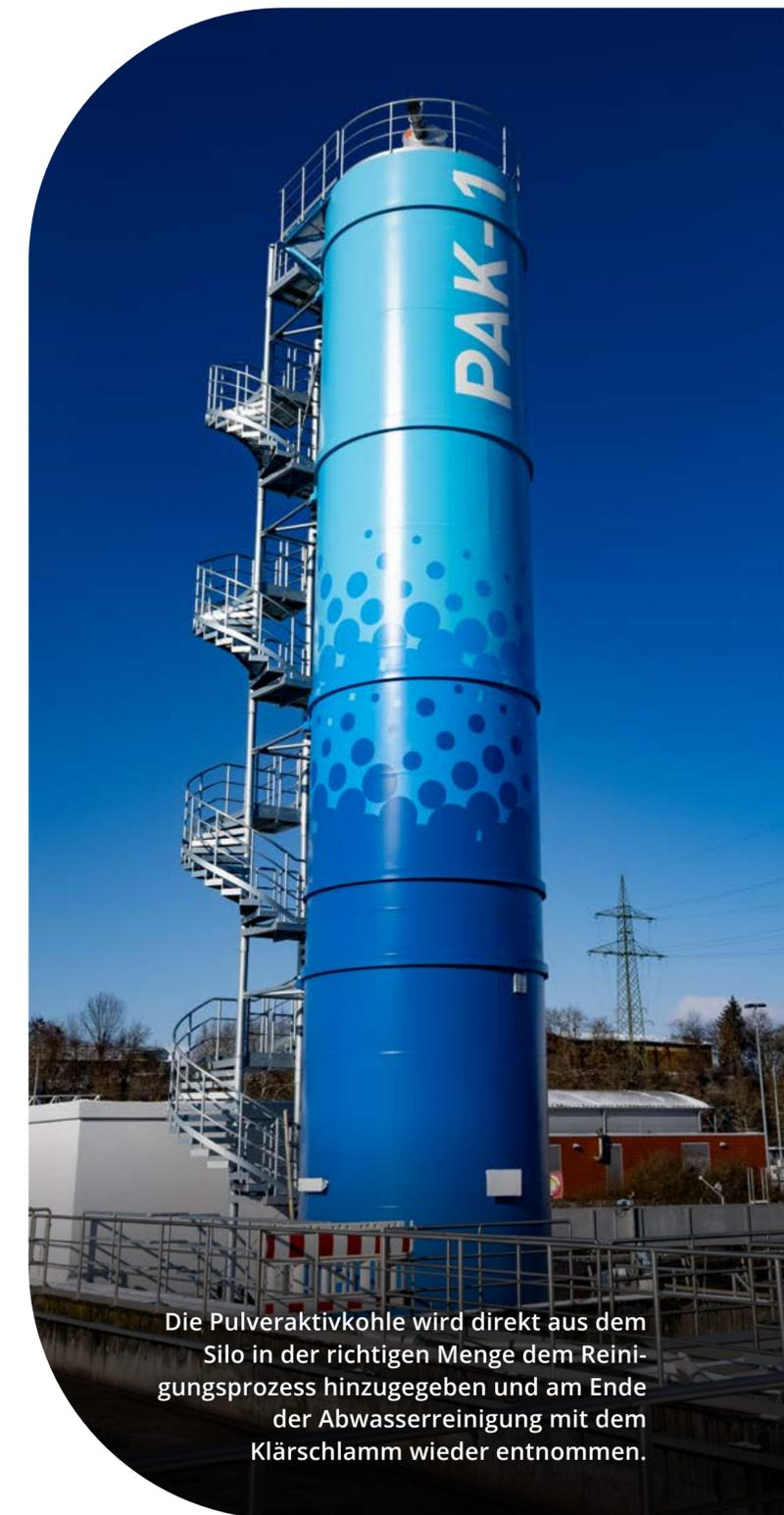
Die Pulveraktivkohle wird direkt aus dem Silo in der richtigen Menge dem Reinigungsprozess hinzugegeben und am Ende der Abwasserreinigung mit dem Klärschlamm wieder entnommen.
