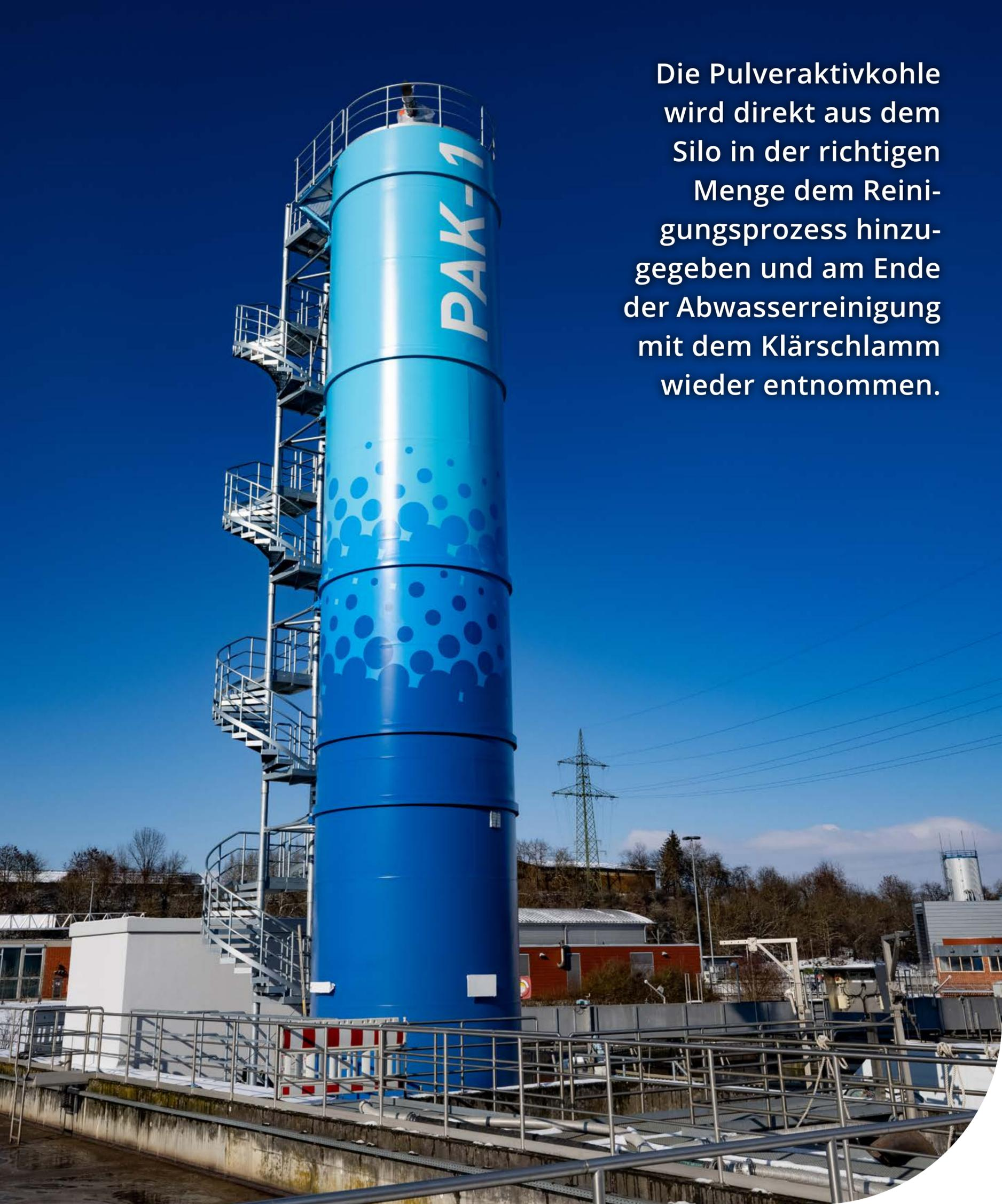
Die Pulveraktivkohle wird direkt aus dem Silo in der richtigen Menge dem Reinigungsprozess hinzugegeben und am Ende der Abwasserreinigung mit dem Klärschlamm wieder entnommen.
